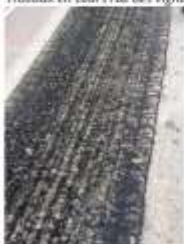
Gravillonnage de la voirie en attendant les terrassements
