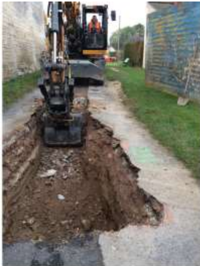
Travaux en cours : rue du Parc
