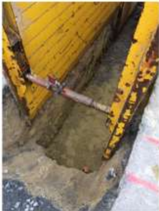
Travaux en cours rue des Vieilles /
