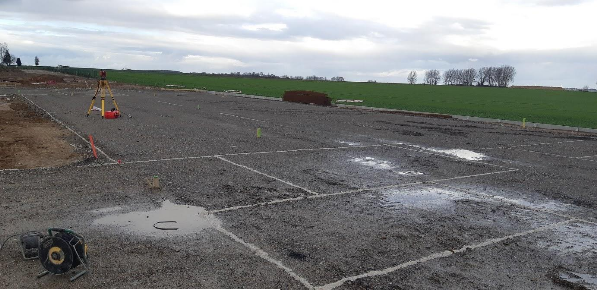
Photo du chantier mi-décembre 2018
